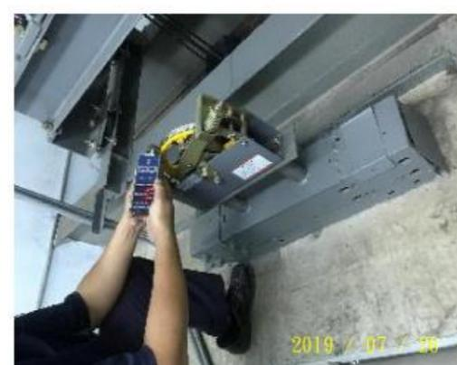
相片 4：調速機動作速度測試
